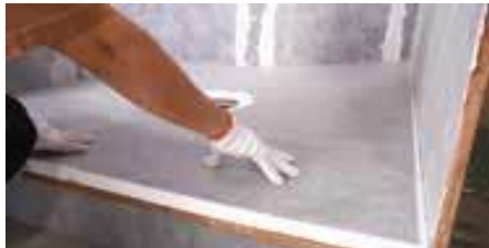
Incorporare la vaschetta nel mortaio
