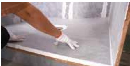
Encastrer le plateau dans le mortier
