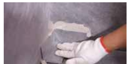
Installer les coins d'étanchéité 1
