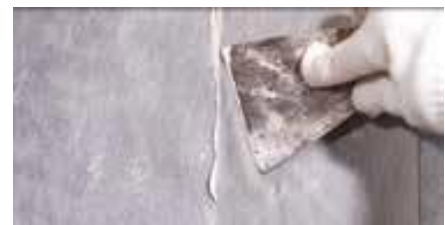
Bedek de waterdichtingsstrip het gewricht
