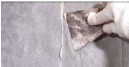
Rendere uniforme la superficie del muro
