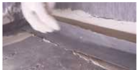
Täck vattentättningsremsan
