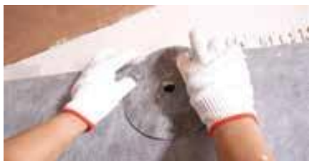
Coprire la guarnizione della valvola miscelatrice
