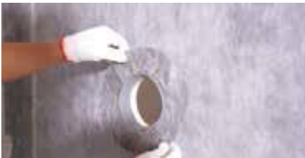
Täck rörtätningen
