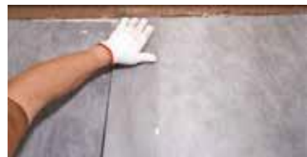
Bedek de waterdichtingsstrip het gewricht
