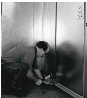
Instale el anclaje
