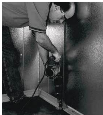
El tamaño de agujero recomendado para el sistema PARABOLT ANCHOR es de 9,5 mm X 5,7 cm.
