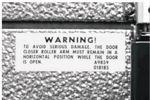
En la sección de la puerta hay una etiqueta de advertencia como recordatorio.
