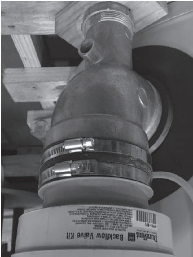
Figure 13. ADAPTATEUR ÉVENT DE SORTIE AU POLYPROPYLENE
