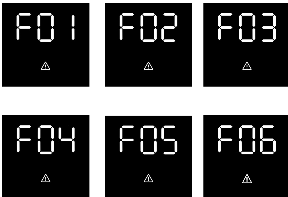
Figure 21. Écrans de défaillances critiques
