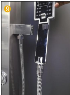
9 Verbinden Sie das Handgerät Brauseschlauch und der Handbrause.
