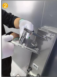
2 Verbinden Sie die obere Brause und den Wasserauslassarm gemeinsam.
