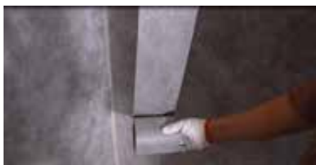
Bedek de waterdichtingsstrip de hoek
