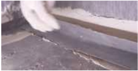
Täck vattentättningsremsan
