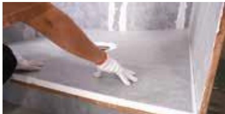
Bädda in brickan i murbruket
