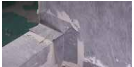
Täck vattentätningshörnen 2
