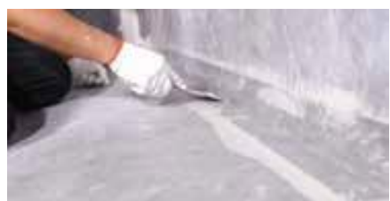
Täck vattentättningsremsan
