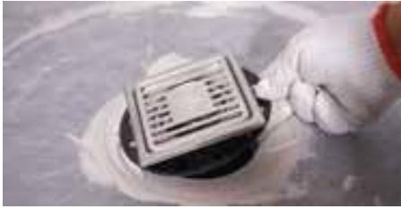
Montera avloppsjusteringsringen
