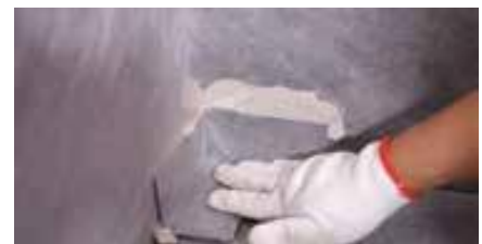
Montera de vattentäta hörnen 1
