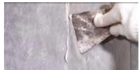
Bedek de waterdichtingsstrip het gewricht
