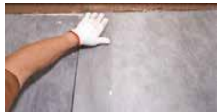
Bedek de waterdichtingsstrip het gewricht
